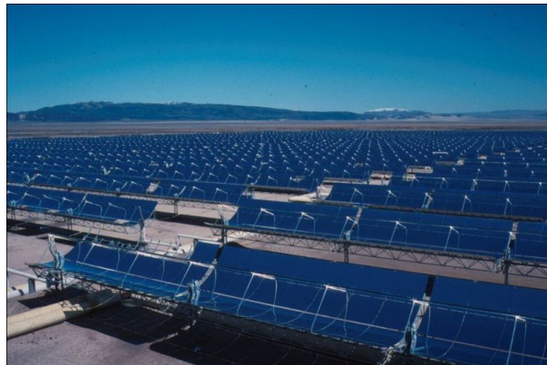
Parabolic trough collector field per l'impianto solare di Kramer Junction, California
